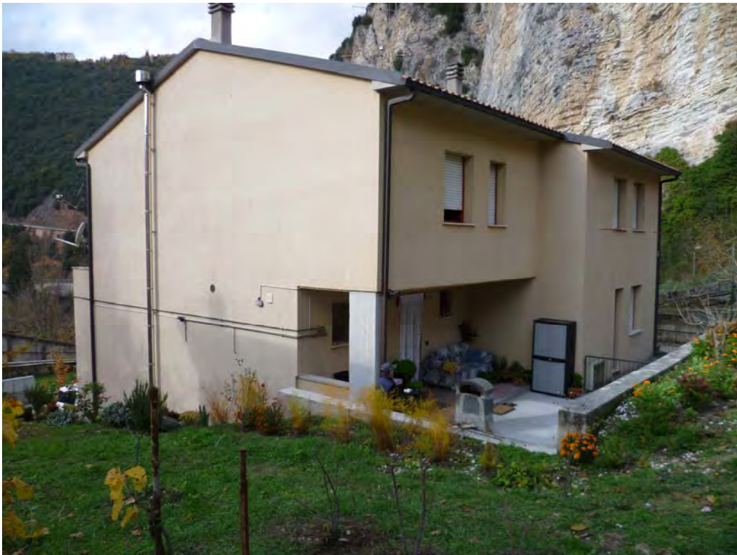
Vista posteriore dell'edificio
